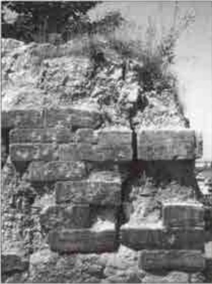
**Abb. 2:** Reste der Stadtmauer Nordhausen, südl. vom Dom (Zustand Juli 1995): Die Gipsstein-Quader (Steigerthaler Bändergips der Werraserie des Unt. Zechsteins) sind nur z. T. gut erhalten. Ein Teil der Blöcke ist an feinen Rissen stark zerbröckelt.
