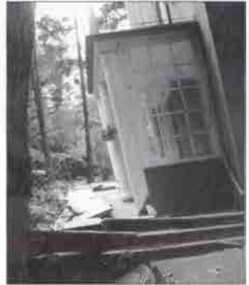
**Abb. 6: Schaden an einer Villa in Wassenberg bei Aachen durch eine erdfallähnliche Pinge (Bergschaden), 1975**
