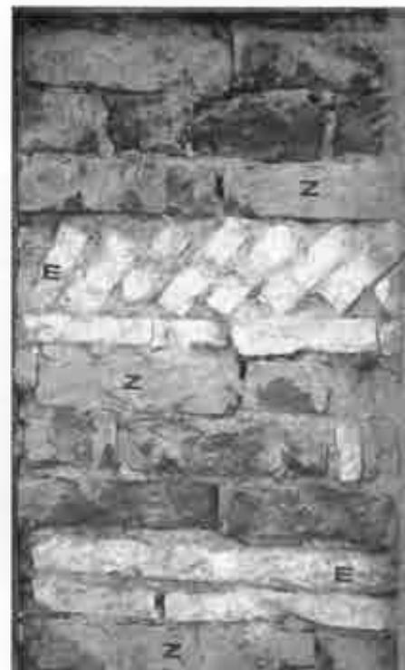
**Abb. 9:** Gefachhausmauerung im Erdgeschoß eines Fachwerkhauses in der Gumpenstr., Altstadt von Nordhausen. Zwischen gebrannten Ziegeln (Z) liegen, z. T. schräg gestapelt, 3-4,5 cm dicke Bruchstücke eines weißen Fußboden-Gipsestrichs (E). Als Bindemittel wurde unreiner Gipsmörtel verwendet. Dieser Einblick in den Wandaufbau war nur während der kurzen Zeit der Erneuerung der Brettverschalung möglich. Zustand: 08. Juli 1995.
