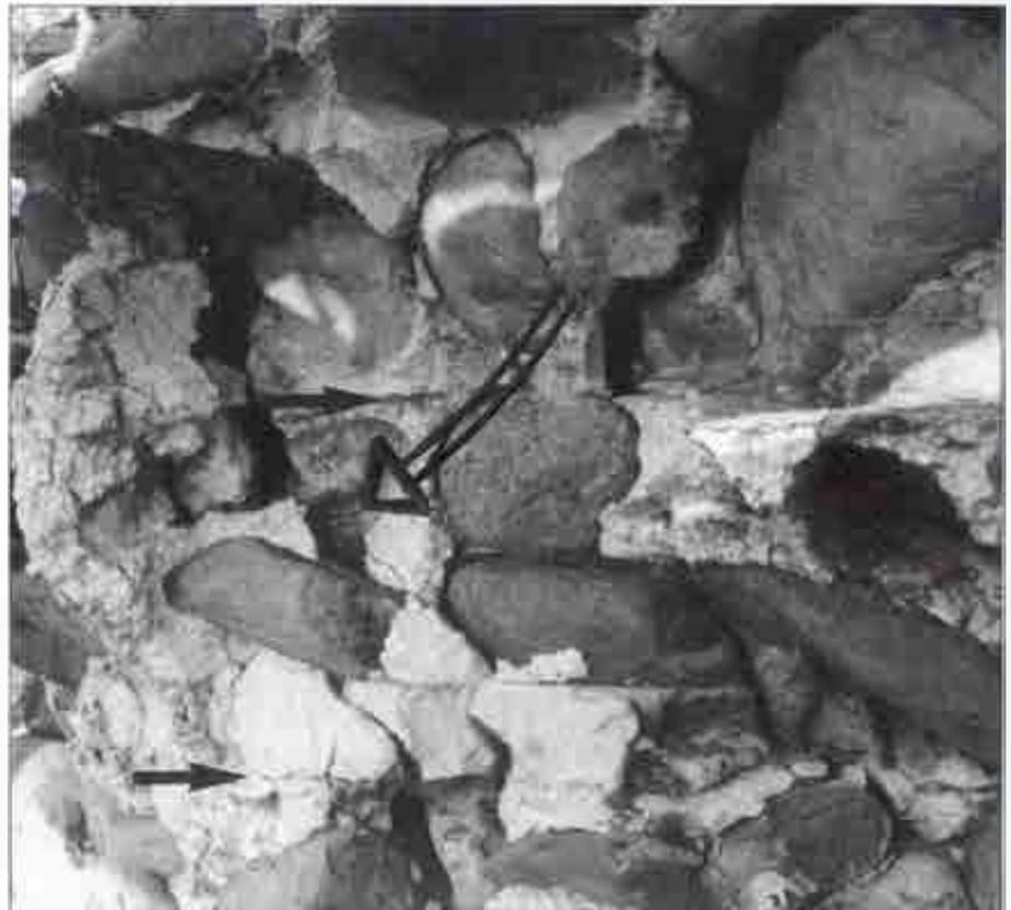
**Abb. 7:** Bergfriedruine der Alten Burg Osterode, Detail des Kernmauerwerks aus großen Geröllsteinen („SösekieSEL“) in lagenweise eingebrachtem Gipsmörtel (Gipsfuß-Beton). Zwei der daraus resultierenden horizontalen Arbeitsfugen sind durch Pfeile markiert. Die klaffenden Risse entstanden durch lateral schiebende Auflastkräfte (gebogener Pfeil) hin auf die links vom Bildrand befindliche vertikale Abbruchkante der 32 m hohen Ruine.
