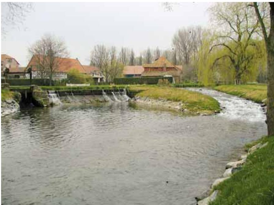
**Abb. 2: Wehranlage bei Besenhausen mit Sohlgleite zur Wiederherstellung der ökologischen Durchgängigkeit**
