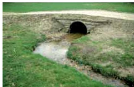
**Bild 37: Auch an Rohrüberfahrten sind Verbesserungen notwendig und meist einfach erledigt – eine kleine Rausche ermöglicht durchgängig passierbares Sediment im Rohr.**
