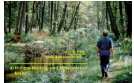
**Bild 28:** Seiteneinengung aus Erlenstämmen – hier mehr als die halbe Gewässerbreite. Es traten über inzwischen mehr als 10 Jahre keine Schäden auf.
