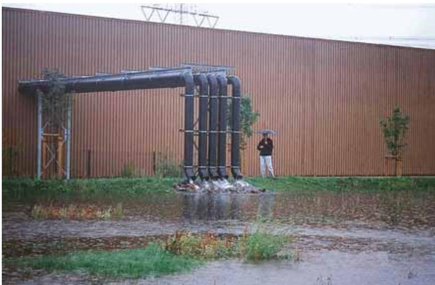
Abb. 14: Offene Ableitung der Dachabflüsse über Rohrbrücken
