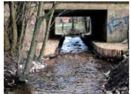
**Bild 38: Die in Bild 10 dargestellte Brücke nach Umbau. Inzwischen ist auch die Betonsohle mit standorttypischem Gewässergrund**
