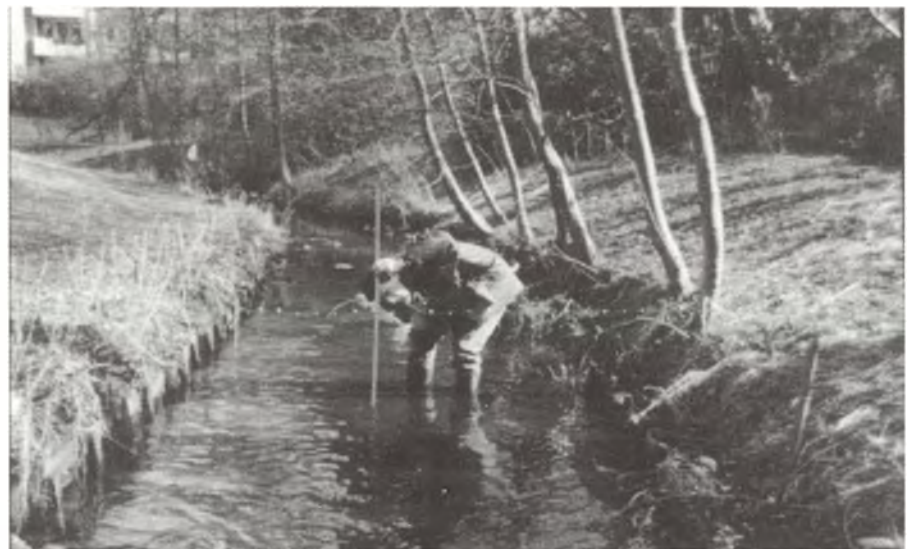
Bild 3: Der im Niedrig- und Mittelwasserbett überbreite, naturfern ausgebaute Bach mit standortuntypischem Sand-/Schlammbett.
