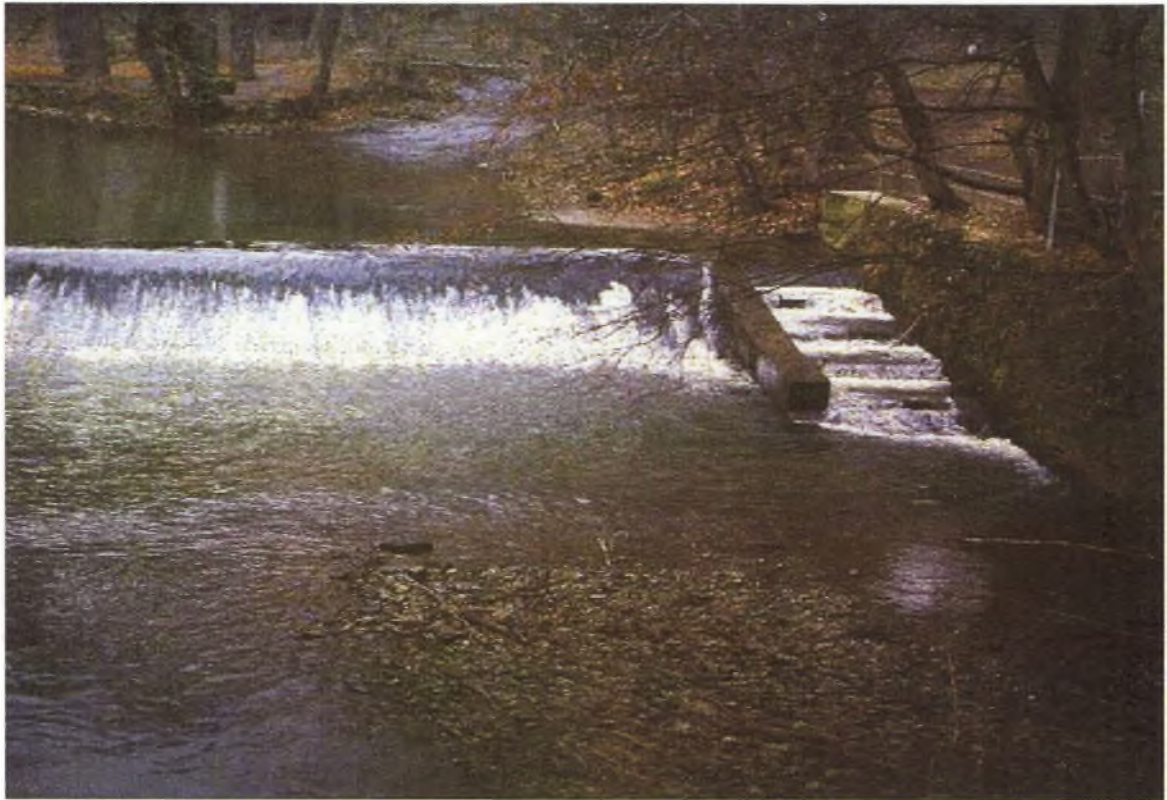
Saynbach vorher (mit Absturz) und nachher (Rampe)
