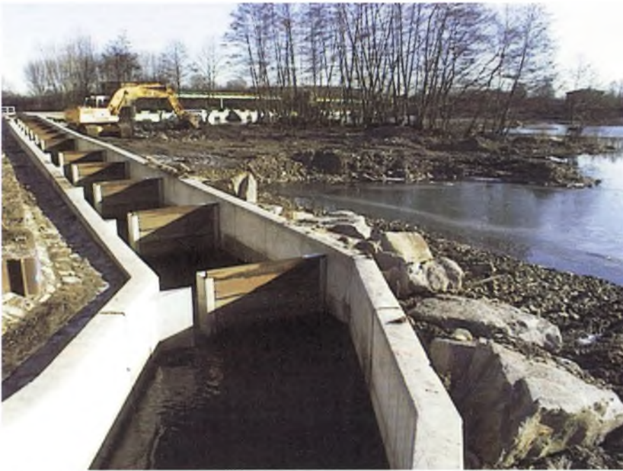
Abb. 3: Schlitzpass am Wehr Stiftsmühle vor der Fertigstellung
