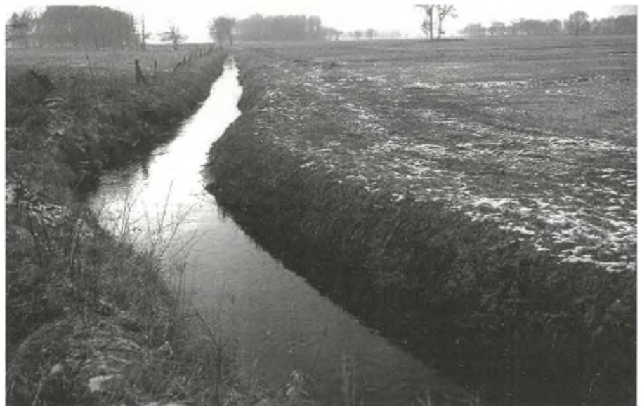
Abb.: 1 Maschinelle Gewässerunterhaltung zerstört den Lebensraum Fließgewässer – dieser flächendeckende Regelverstoß gegen Fachlichkeit und Recht muss ein Ende haben.
