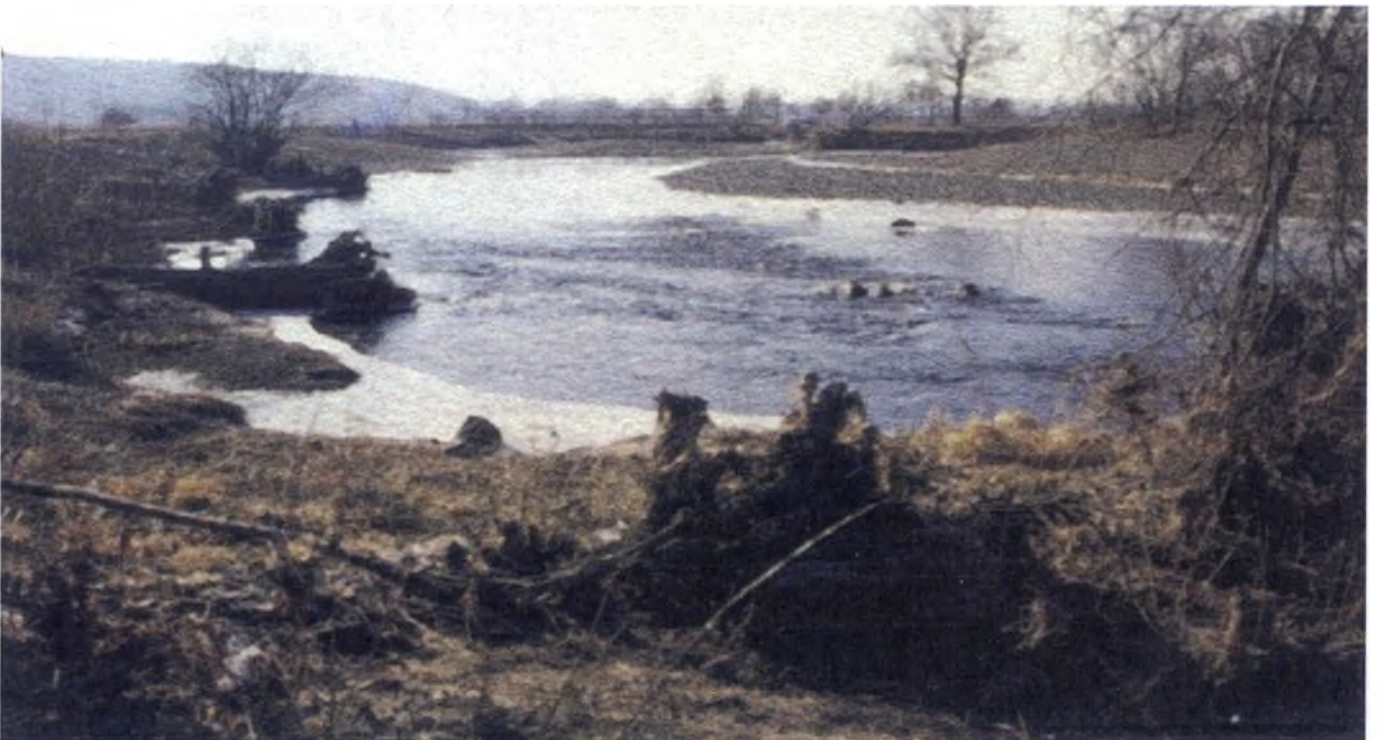
Abb. 9: Gewässerbettaufweitung und Uferschutz
