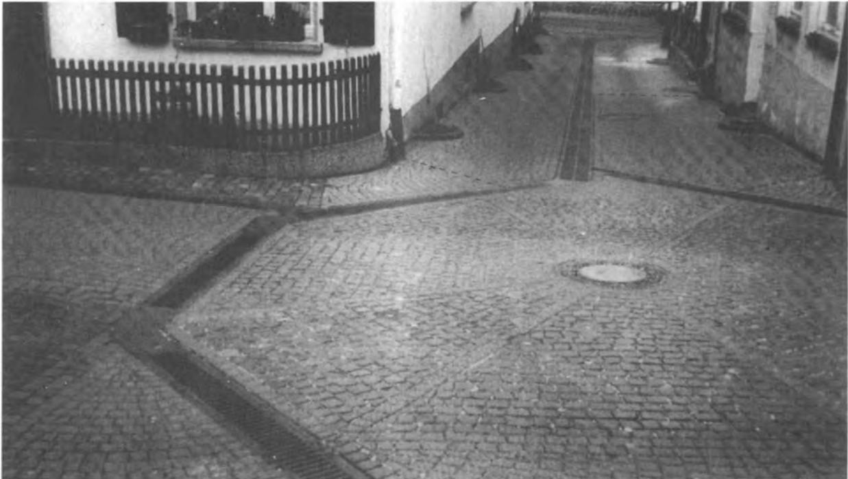
Abb. 2. Oberflächenentwässerung in der Kleinstadt Amöneburg/Mittelhessen.
