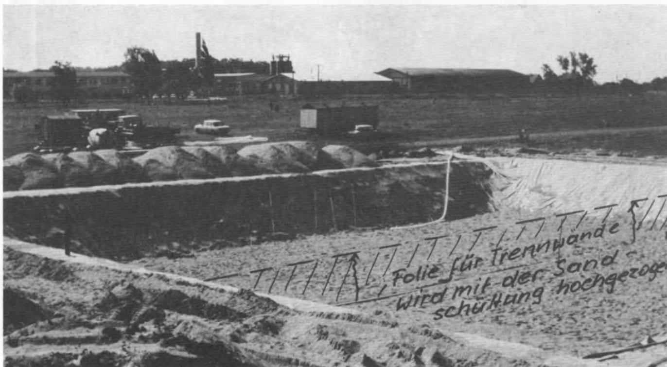
Abbildung 5: Bau von 3 Beckeneinheiten in Rade
