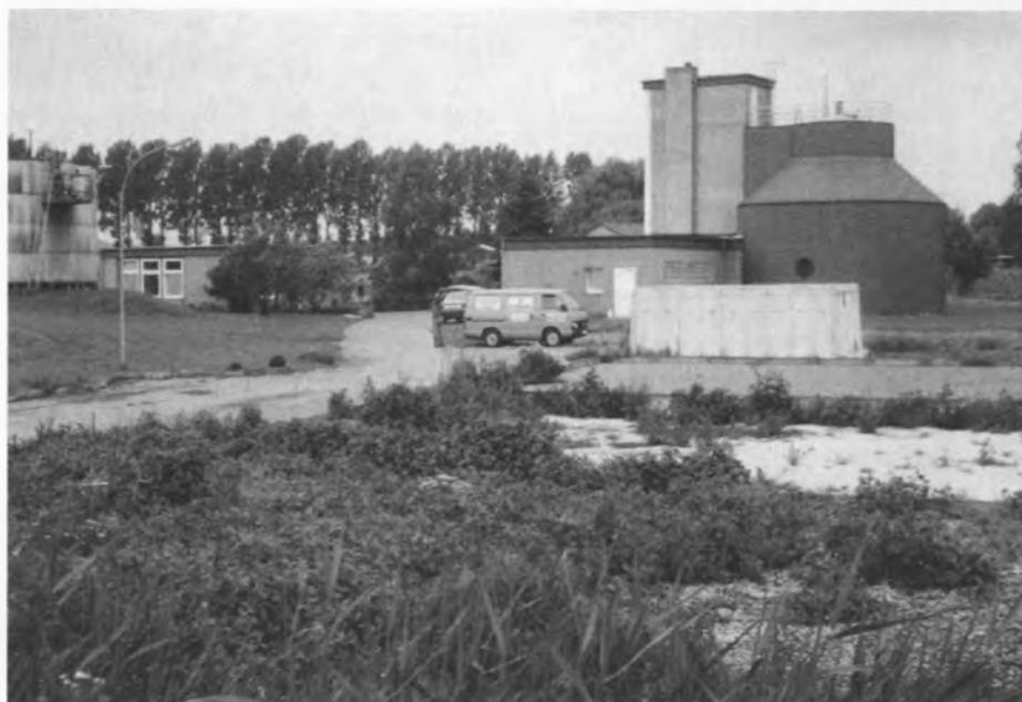
**Abb. 3: Ein Klärwerk für 3000 Einwohnerggleichwerten EGW mit Hochbehältern und Trockenbeeten zur Klärschlammbehandlung.**
