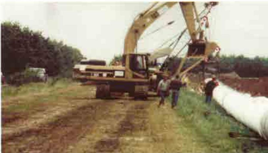
Abb. 7: Bauvorbereitende Maßnahmen helfen Schadverdichtungen zu vermeiden. Das Foto zeigt eine im Vorfeld der Baumaßnahme begrünte Fahrtrasse, die durch die Transpiration der Pflanzen entwässert wurde, sodass der Boden tragfähig war. Gleichzeitig wurde die Baumaßnahme gezielt in das Sommerhalbjahr gelegt, um Vernässungen während der Bauphase – wie sie im Winter üblich sind – weitgehend ausschließen zu können (Foto: G. Dumbeck).
