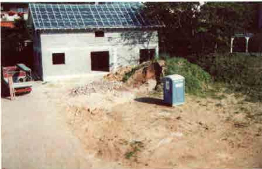
Abb. 6: Fehlende Bau fenster führen durch unkontrolliertes Befahren zu großflächiger Bodenschadverdichtung, die im Verhältnis zur überbauten/versiegelten Fläche durch aus ein Vielfaches ausmachen kann (Foto: N. Feldwisch).
