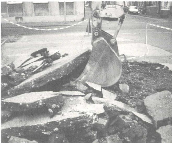
Abb. 9. Aufbrechen der Bitukiesdecke auf dem Mittelstreifen.
