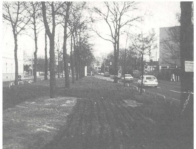
Abb. 10. Nach vorsichtiger Lockerung des Untergrundes wird ein humusreiches Substrat angegedeckt.
