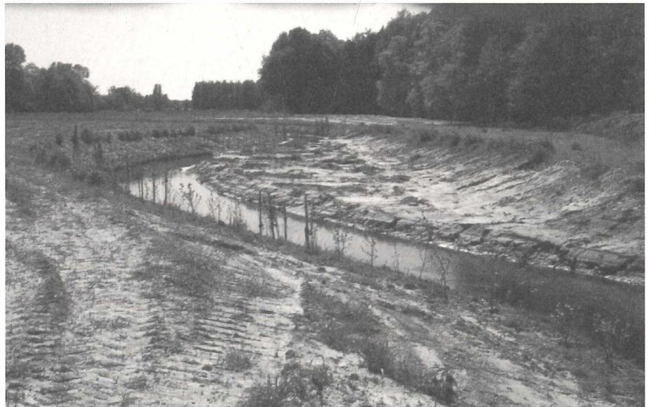
*Abb. 5. Flurneuordnung Türlau Fahrenhorst - Renaturierung der Kleinen Aller. Der neue Gewässerlauf nach der Bauausführung.*
