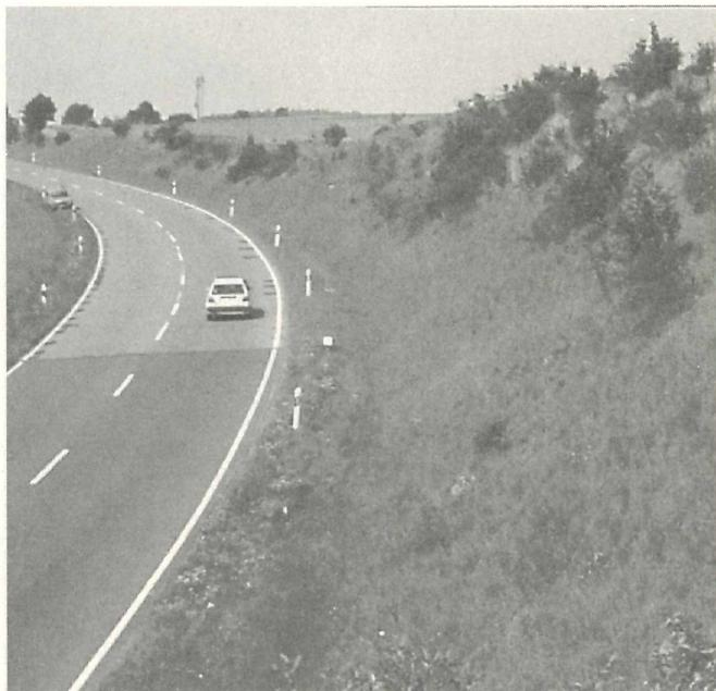
**Bild 12: Lockere, auf die Oberböschungen konzentrierte (Initial-)Pflanzungen** benötigen zwar länger bis sie sich schließen, gewähren aber vielen Kleintieren gerade deshalb zusageudere Lebensbedingungen und ihre Unterhaltung erfordert deutlich weniger Aufwand als die üblichen, Loch an Loch gesetzten Reihenpflanzungen.
