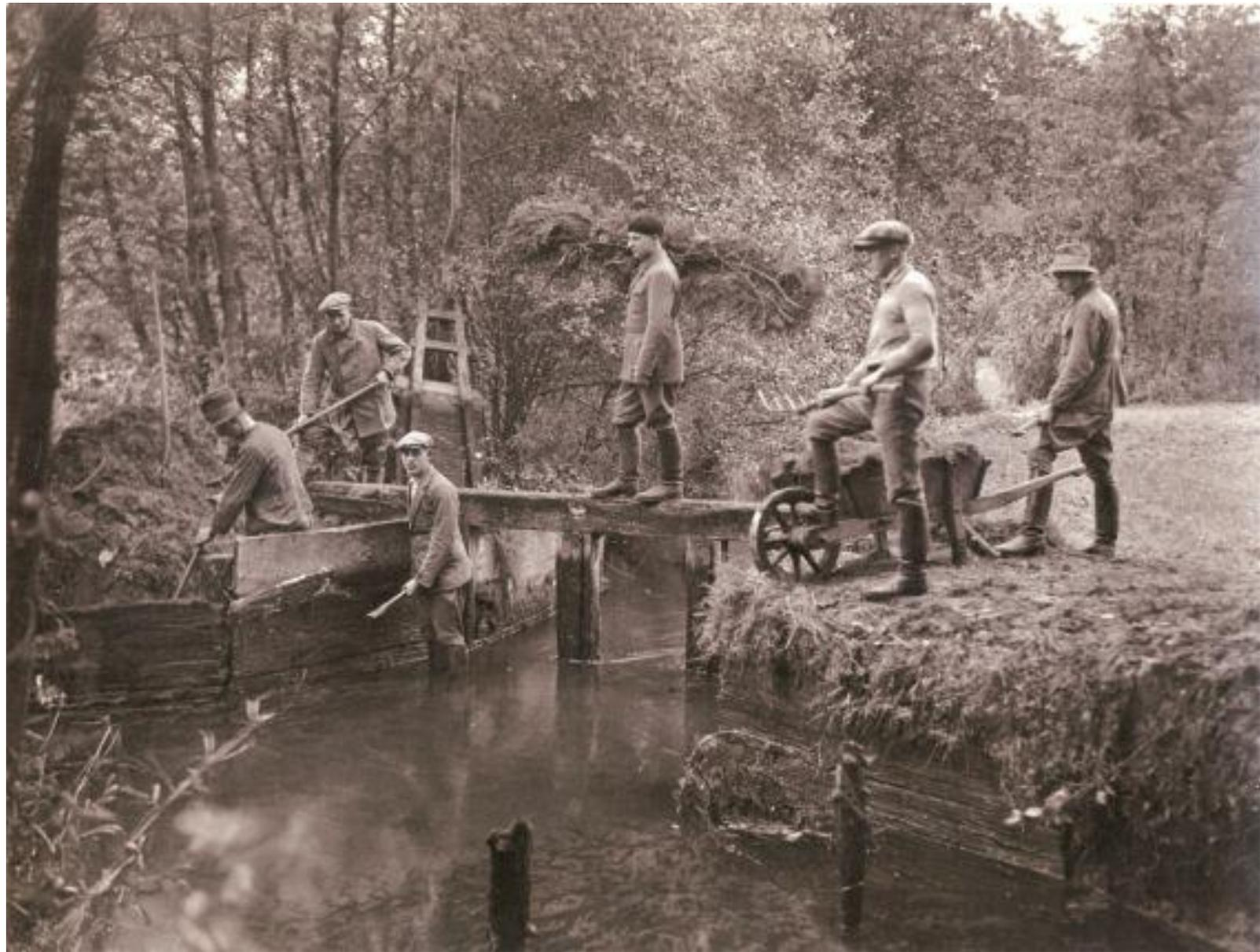
Instandsetzungsarbeiten an einer Stauschleuse in der Hardau durch Schüler der Wiesenbauschule um 1930
