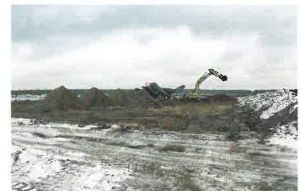
Abb. 8 Munitionsberäumung – Einsatz Siebanlage
