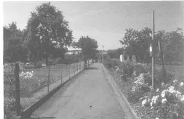
Foto 2: Ein Beispiel für eine Wegefläche, auf der das Niederschlagswasser nicht in die Seitenräume fließen kann, sondern über die Oberflächenentwässerung abgeführt wird und so für die Grundwasserneubildung verloren ist.
