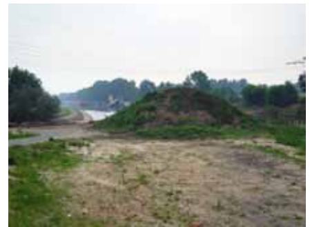
Abb. 3: Mittellandkanal, Stichkanal nach Osnabrück, Ausbau für Großmotorgüterschiffe (Foto: Zittlau)
