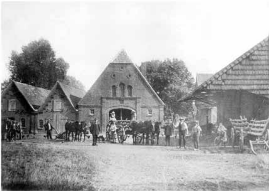
Abb. 4: Fast zerstört und in seiner Bedeutung eher zufällig erkannt: Bauernhof in Lüdinghausen, dessen Haupthaus im Kern den älteste bekannten Vierständerbau überhaupt birgt, der 1517 errichtet wurde. Das Foto von etwa 1930 zeigt ganz rechts die Wagenremise von etwa 1910, ganz hinten den Speicher von etwa 1790, dann das Haupthaus, hier mit einem neuen Giebel von etwa 1925. Ganz links der etwa 1890 errichtete Schweinestall, wenige Jahre später durch Überdachung der Mistlege mit dem Haupthaus verbunden. 500 Jahre Entwicklung der Landwirtschaft in einem Hof!
